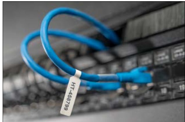
P-Flags sind haltbare Kabeletiketten, die sich schnell und mit einer Hand anbringen lassen.
