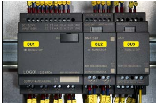
Helatag für die Kennzeichnung im Schaltschrank.
