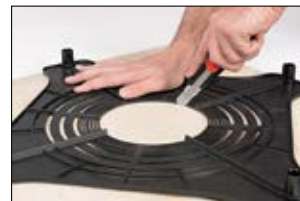
Verwenden Sie SpotClip-Plate als Schablone, um das Befestigungsloch in der Deckenplatte auszuschnitten.
