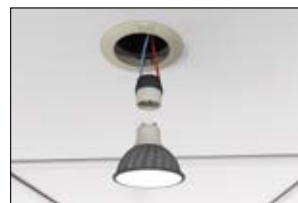
3. Leuchtmittel mit dem Sockel verbinden und in Einbaustrahlergehäuse einsetzen.
