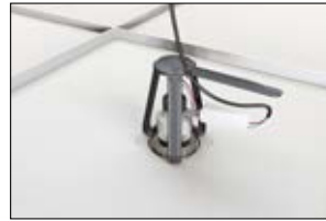
4. Netzteil anschließen und Leitung am Kabelhalter befestigen.
