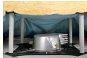
SpotClip-Plate kombiniert mit SpotClip-Caps und IRL-Leerrohre.
