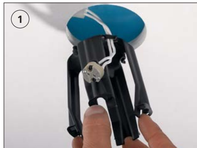
Zuleitung befestigen, Montagelaschen zusammendrücken und in die Deckenausparung einsetzen.
