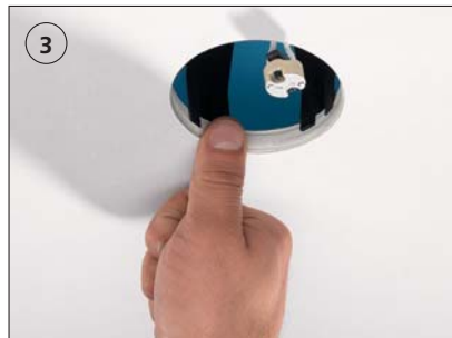
Haltehorn in die Gipskartonplatte eindrücken, um nachträgliches Verrutschen zu verhindern.
