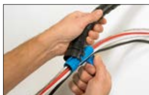
Helawrap auf das Werkzeug aufstecken.
