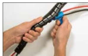
Helawrap wird nun nach dem Reißverschlussprinzip montiert.
