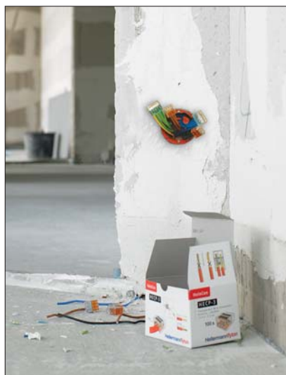
HelaCon Plus in einer Aufputzinstallation.
