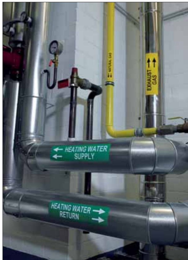
Eindeutig lesbare Beschriftung von Rohren und Leitungen.
