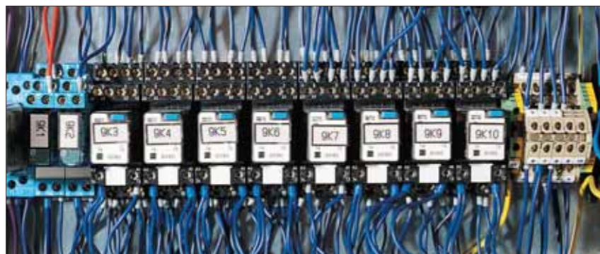
Sicherheit und Übersichtlichkeit im Schaltschrank: Helatag®.
