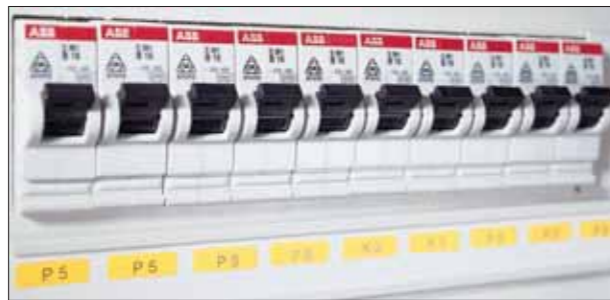
Kennzeichnung im Schaltschrank.
