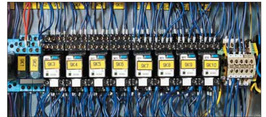
Sicherheit und Übersichtlichkeit im Schaltschrank: Helatag®.
