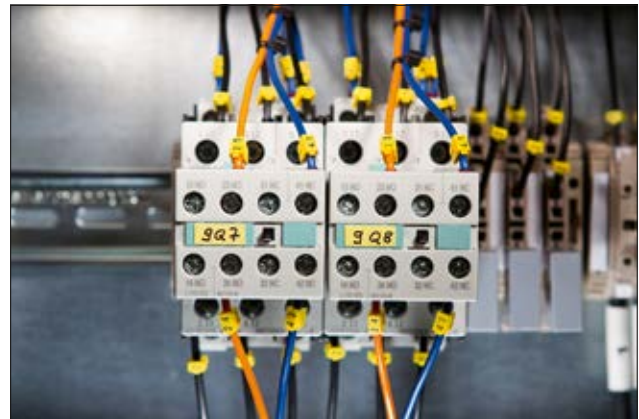
Sicherheit und Übersichtlichkeit im Schaltschrank.
