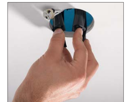
Die 4 flexiblen Montagelaschen rasten einfach in die gewünschte Position ein.
