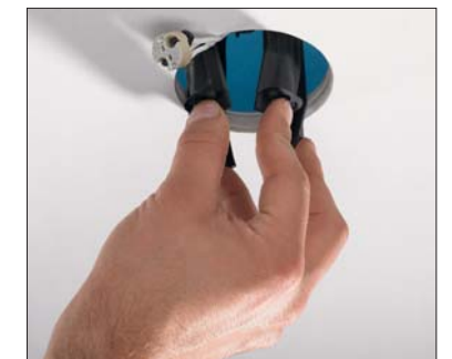
Die 4 flexiblen Montagelaschen rasten einfach in die gewünschte Position ein.
