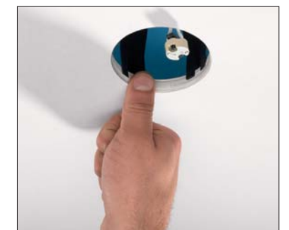
Haltedorn in die Gipskartonplatte eindrücken, um nachträgliches Verrutschen zu verhindern.
