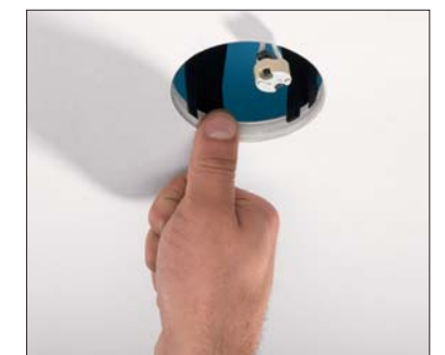
Haltedorn in die Gipskartonplatte eindrücken, um nachträgliches Verrutschen zu verhindern.
