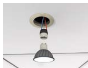
3. Leuchtmittel mit dem Sockel verbinden und in Einbaustrahlergehäuse einsetzen.
