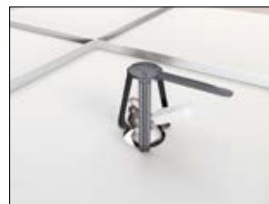
3. Installation des Einbaustrahlers.
