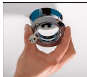
3. Der Einbaustrahler kann nun sicher und verlässlich installiert werden.
