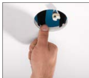
2. Halteorne in die Gipskartonplatte eindrücken, um eine Verschiebung zu verhindern.
