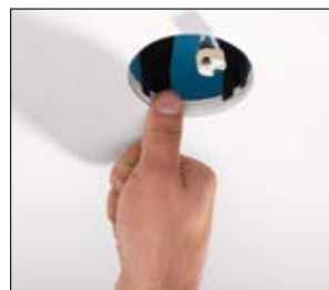
3. Haltedorne in die Gipskartonplatte eindrücken, um eine Verschiebung zu verhindern.
