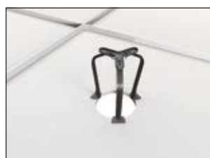
2. SpotClip-Kit positionieren und mit den Haltedornen gegen Verrutschen sichern.
