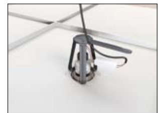
4. Netzteil anschließen und Leitung am Kabelhalter befestigen.
