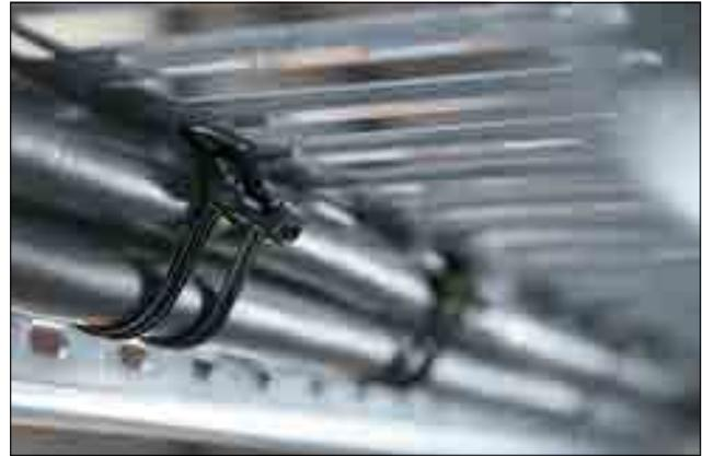
Kabelbinder der KR-Serie werden mit dem EVO KR-Kabelbinderwerkzeug angebracht.
